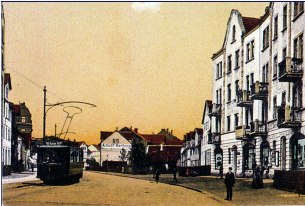
Die Straßenbahn in der Leipziger Anfang des 20. Jahrhunderts, im Hintergrund das Haus von Malermeister Hartung und rechts davon eine kleine Kastanie Foto: Stadtteilzentrum Agathof e. V.
